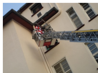
Abbildung 14: Einsatz der Drehleiter (h)
