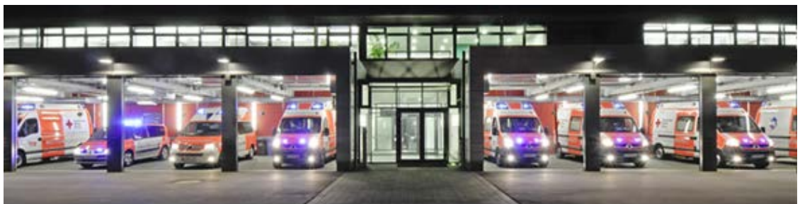
Abbildung 19: Fahrzeughalle mit Einsatzfahrzeugen
